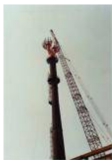
Sostituzione bruciatori esalazione gas candela altiforni Italsider (Bagnoli 'NA')
